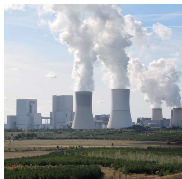
Einsatz von EVD-Gaswarn-Managementssystemlösungen in Kraftwerken
